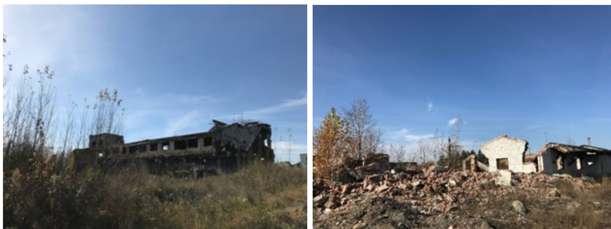
Рис. 1. Разрушенные цеха на промплощадке ВСЭ
