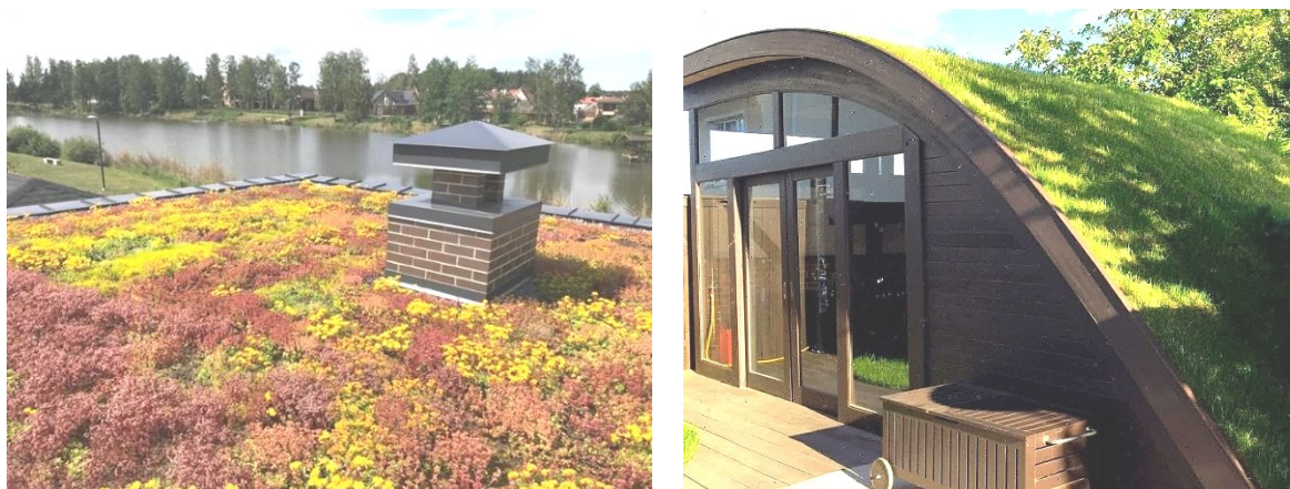
Рис. 2. Живые кровли от «Фрей»: плоская кровля гаражного комплекса в Петергофе (слева); скатная кровля беседки в Перми (справа)
