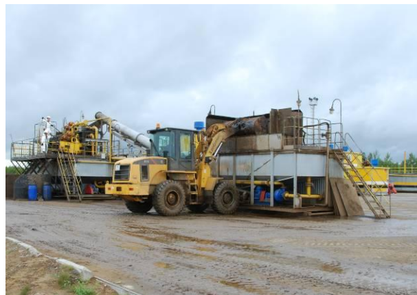
Рис. 3. Работа установки по обезвреживанию твердых нефтяных отходов
