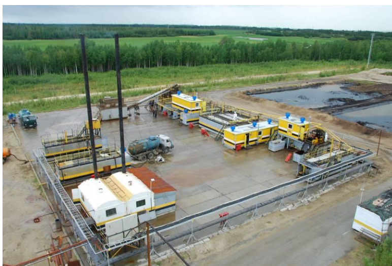
Рис. 4. Комплексная установка по переработке жидких и обезвреживанию твердых нефтяных отходов
