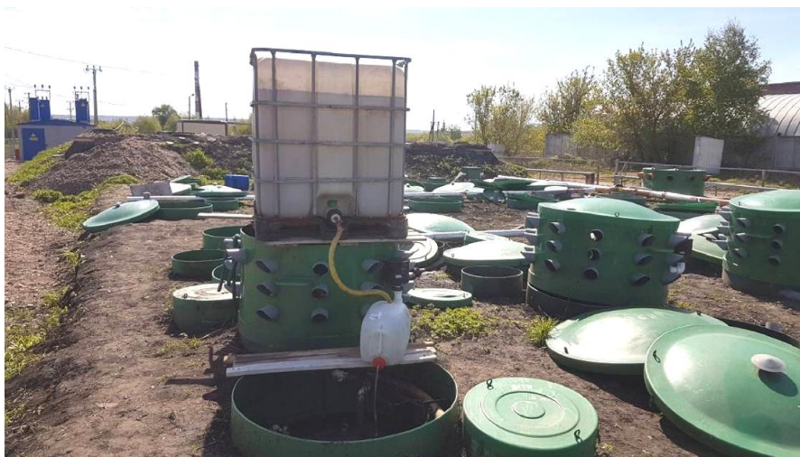
Рис. 1. Дозирование раствора препарата «Мефосфон» в поток осветленных сточных вод
