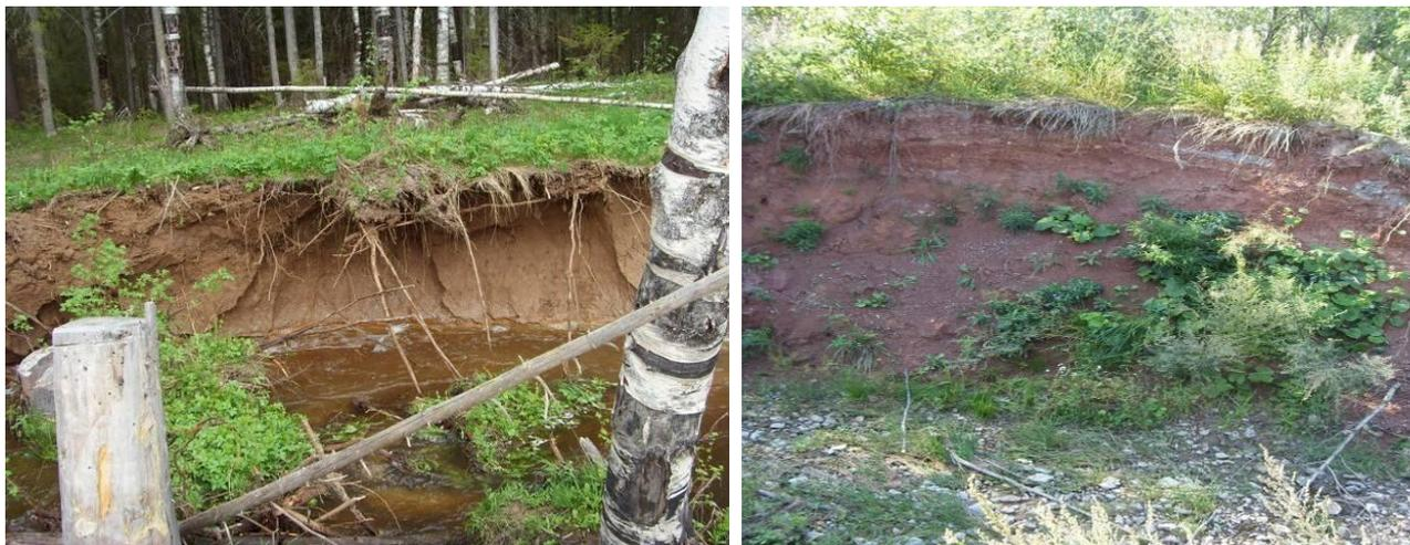
Рис. Размыв неукрепленного русла траншейного водосброса
